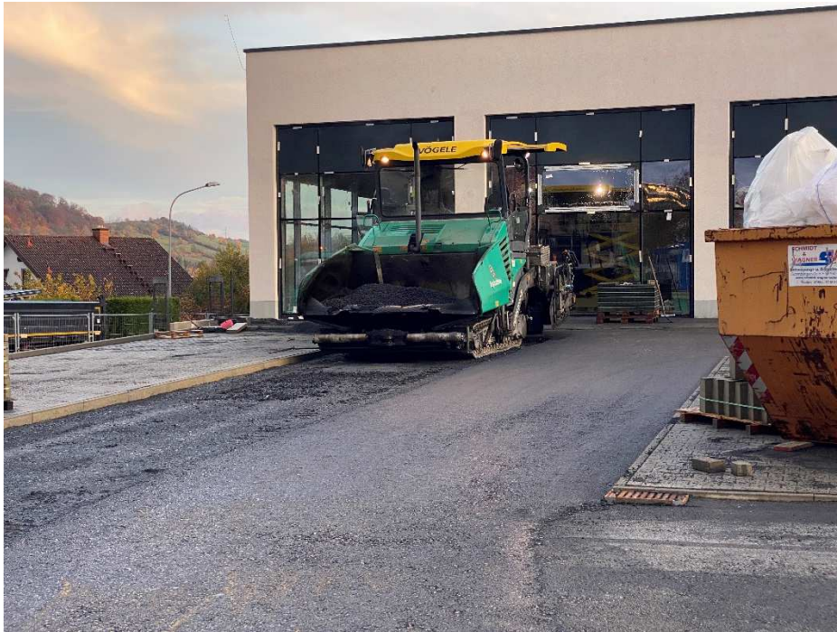
Asphalteinbau am 28.10.2020
