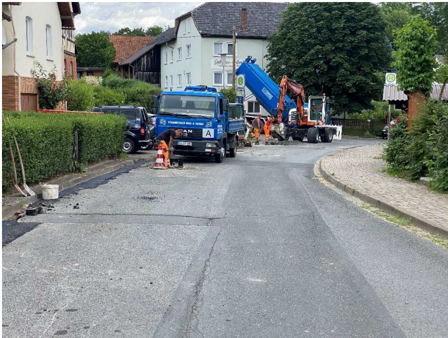
Randplattenausbau am 01.07.2020
