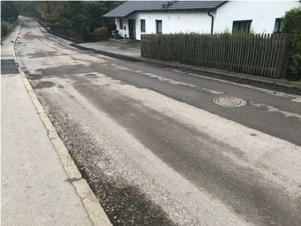
Fräsarbeiten Angerstraße am 29.10.2019
