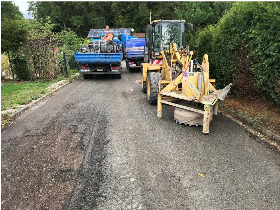
Schachtabdeckungen Erneuerung am 01.10.2019
