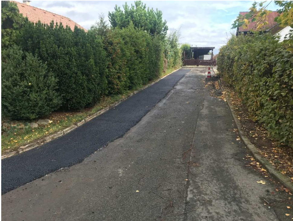
Asphalttragschicht Einbau am 01.10.2019
